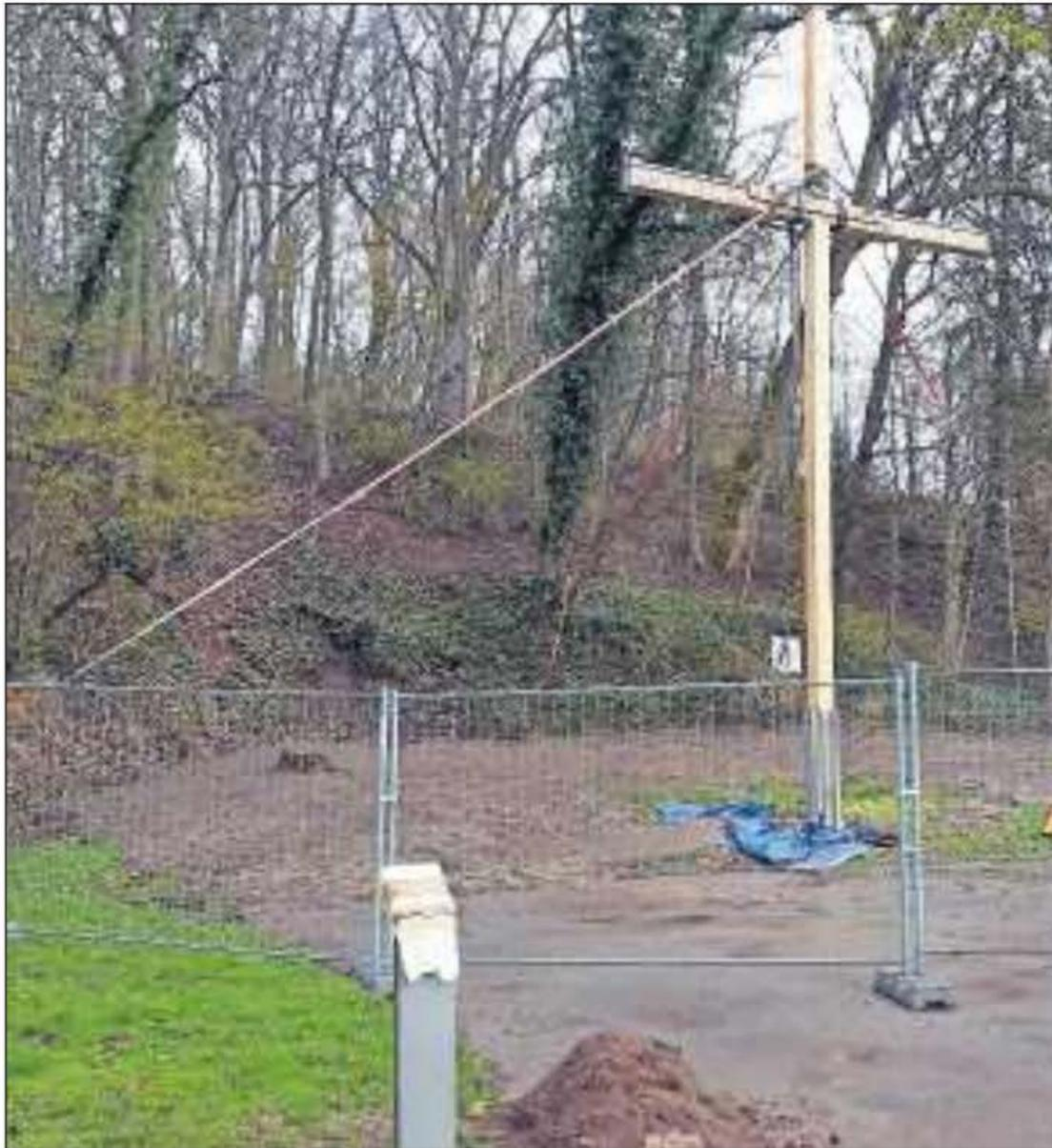
**Das Friedenskreuz steht bereits im Fundament, wird aber noch von Seilen gehalten, bis der Beton ausgehärtet ist. Im Vordergrund eine noch abgedeckte Infosäule.**
